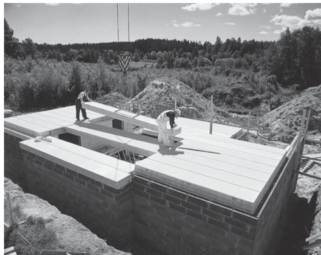
Siporex-välipohjan asennus.
