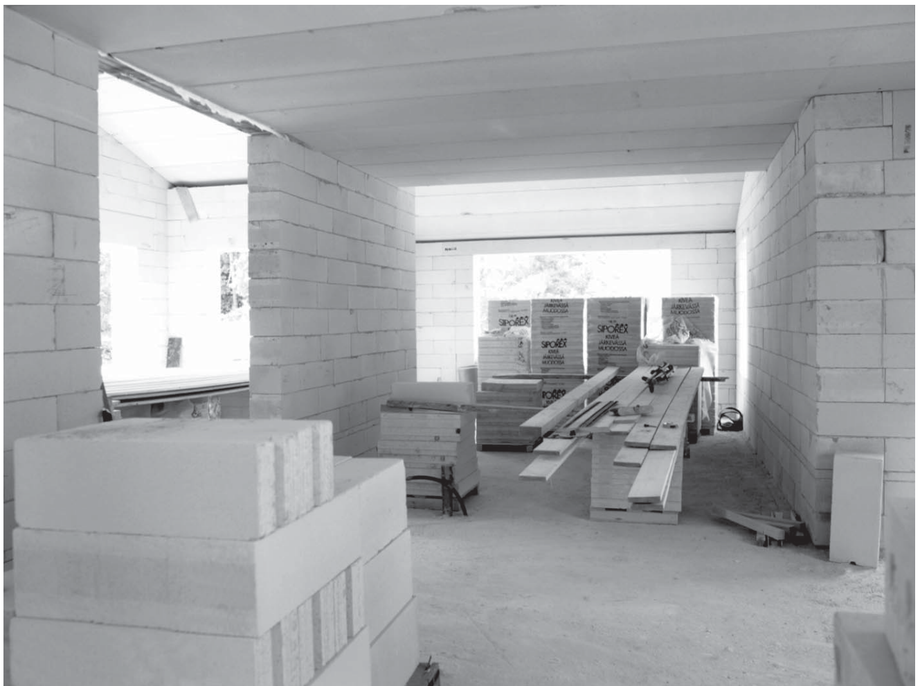
Pientalon runko siporex-harkoista ja -elementiestä.
