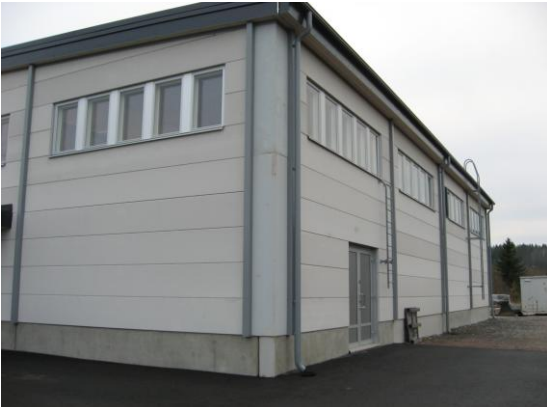
Kuva 5. v. 2009 mitatun (2007 valmistunut) 434 m 2 hallin ilmavuotoluku n 50 oli 0,7 1/h. /3/
