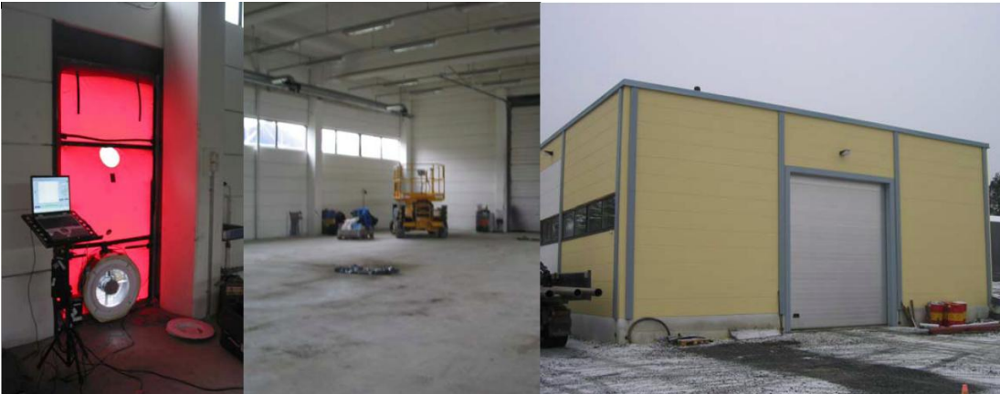
Kuva 3. v.2004 valmistuneen ja v. 2008 mitatun Pirkanmaalla sijaitsevan 420 m 2 teollisuushallin ilmavuotoluku n 50 oli 1,4 1/h. /2/
